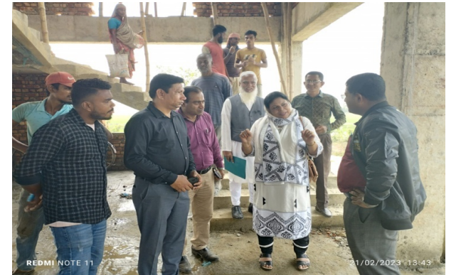
অফিস কাম ট্রেনিং সেন্টারের নির্মাণ কাজ পরিদর্শন প্রকল্প পরিচালক (যুগ্মসচিব) জনাব শাহনাজ বেগম নীনা
